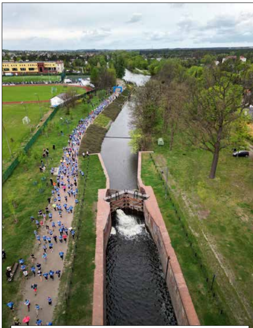
Fig. 5. Bydgoszcz Canal. Photo: R. Sawicki
